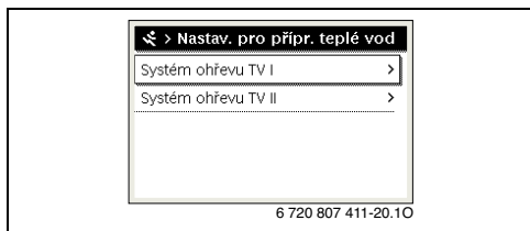
Obr. 22 Menu Nastavení teplé vody
